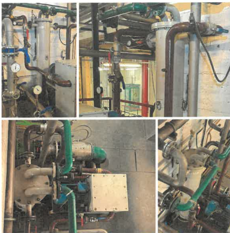
Zdjęcie 1 Wymiennik chłodzenia łożyska turbiny
